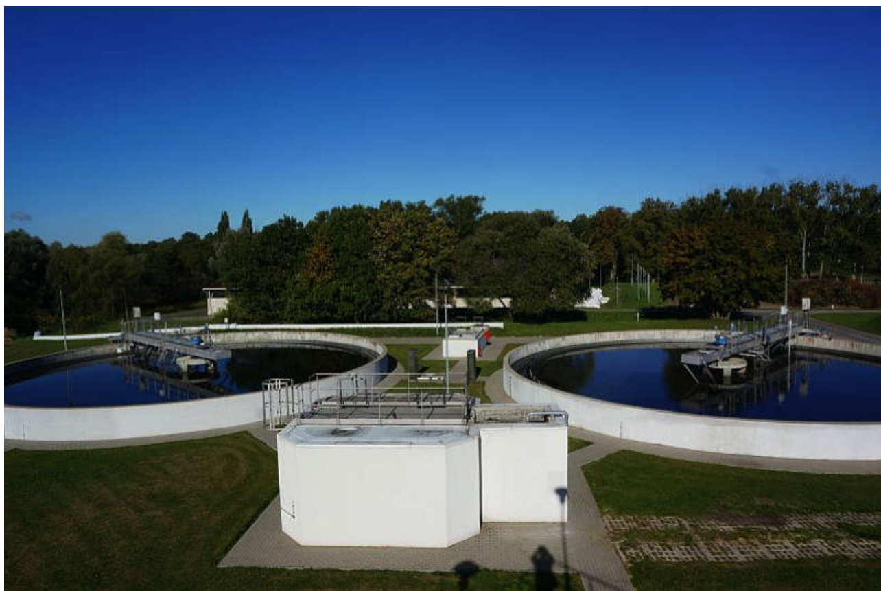
W 2015 roku dzięki środkom z WFOŚiGW w Olsztynie zmodernizowano m.in. trzy oczyszczalnie ścieków Fot. Archiwum
